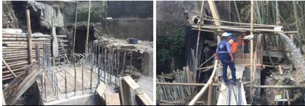
Figura No. 5 Obra CONSTRUCCIÓN CONEXIÓN PUENTE CHUNE
