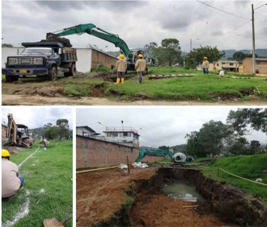
Figura No. 1. Obra INTERCEPTOR EJIDO DERECHO I A
